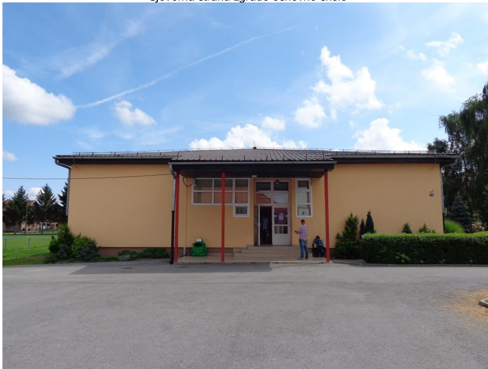
Sjeverna strana zgrade osnovne škole
