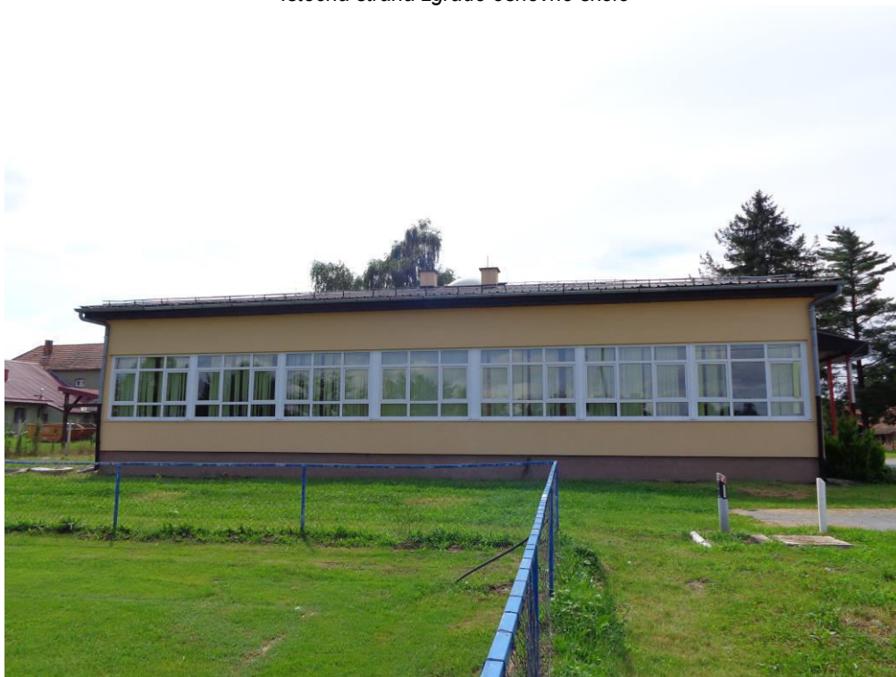
Istočna strana zgrade osnovne škole
